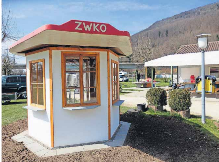
Renoviert: das einstige Kassenhäuschen auf dem Camping Ruppoldingen.
