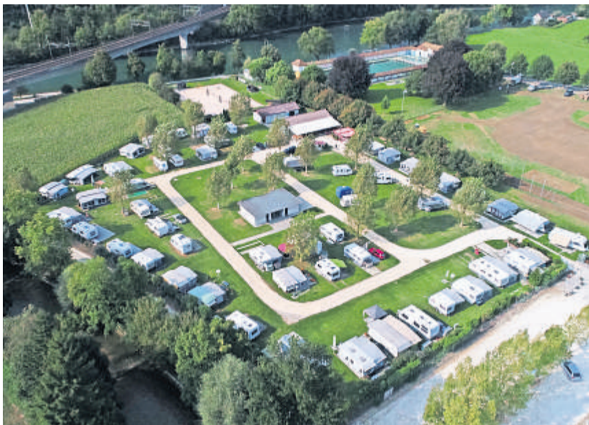
Drohnen-Ansicht des Camping-Platzes Wiggerspitz in Aarburg.
