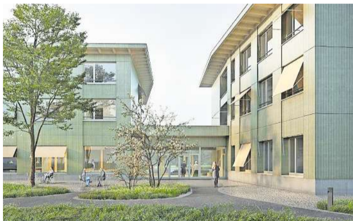
Die Aussenansicht des Wohnbereich-Neubaus. Visualisierung: zvg
